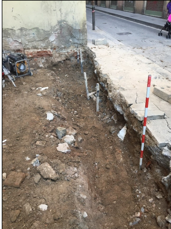
Fig. 5. Rasa 1, en la part que dona a la façana del carrer Riereta, en la seva zona oest.
